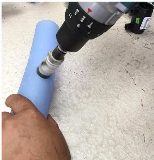
À l'aide d'une mèche emporte-pièce, percer le tuyau. Le diamètre de perçage doit être équivalent au diamètre intérieur du "T" + 1/16".
