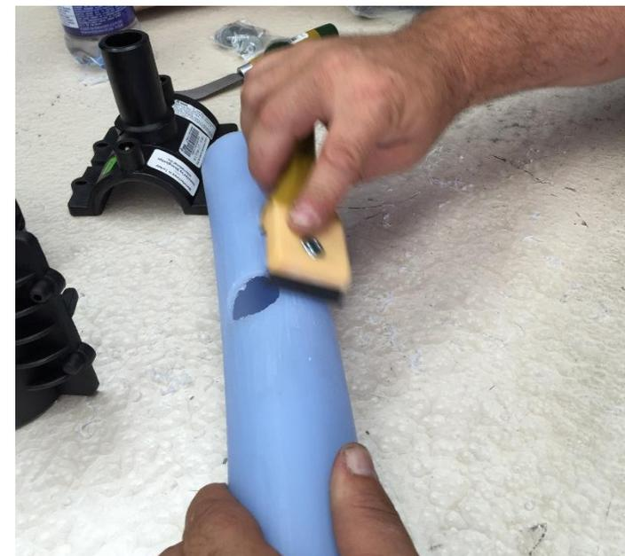
Préparer la surface de même façon qu'une bague en **grattant la surface** du tuyau et nettoyer à l'alcool isopropylique le tuyau et l'intérieur de la selle.
